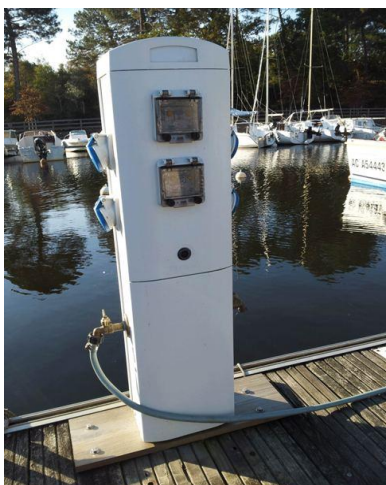
Nouvelles bornes électriques sur les pontons Normes européennes
