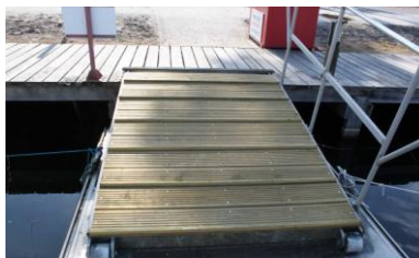
Réfection des coupées des pontons
